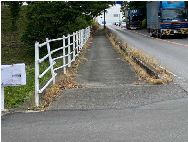
写真＝桑島大橋東側の歩道
